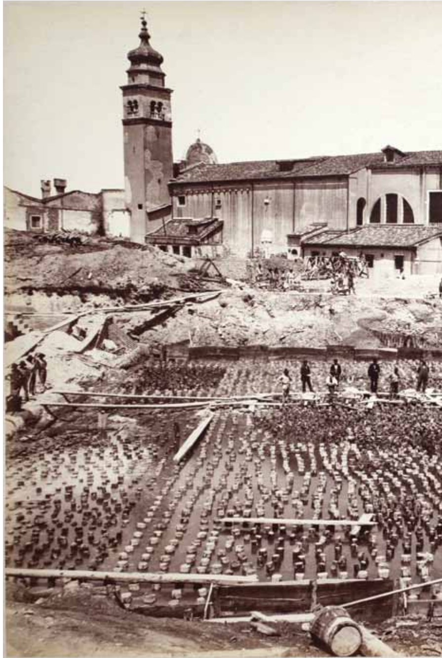
III.5 - Acquedotto di Venezia: cisternone
