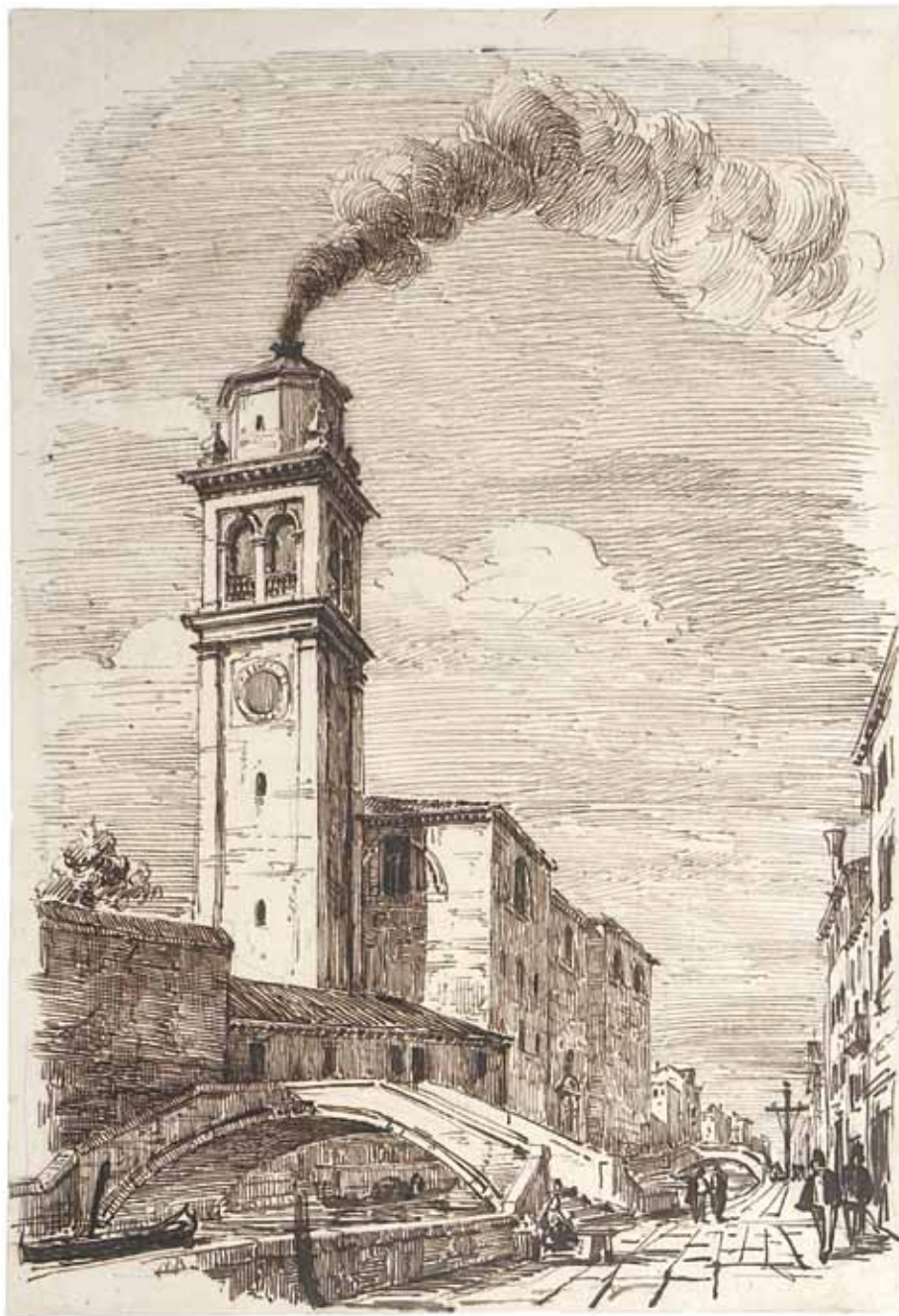
IV.6 - Giovanni Pivdor, La chiesa di San Girolamo a Cannaregio trasformata in molino a vapore con il campanile che funge da ciminiera , 1850 ca., disegno (44,3×31). GdsMCVe, Cl. III, n. 5333d.
